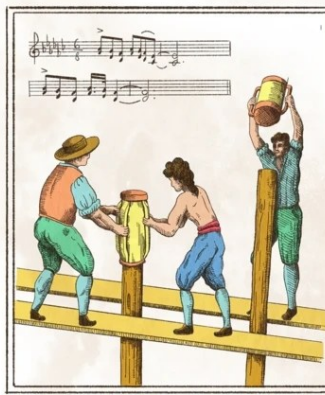
将木桩打入淤泥的人被称为“battipali”(意为打桩工)，他们在工作时会唱歌来保持节奏。
