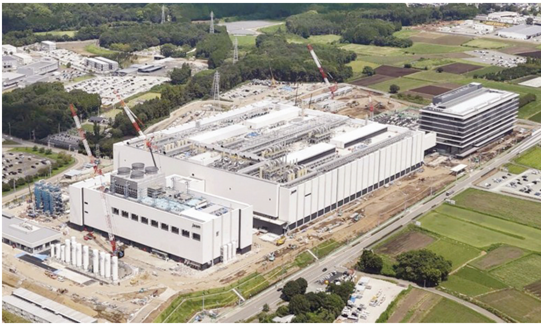
图为2023年8月还处于建设中的台积电日本熊本工厂。
