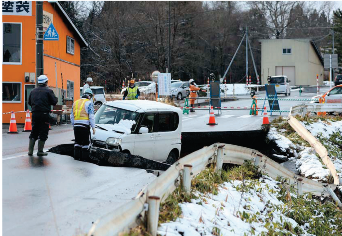
12月9日在日本青森县东北市拍摄的一辆停在塌陷路面上的车。
