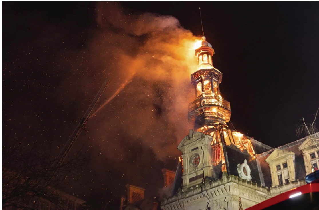
火灾损毁巴黎19世纪第12区市政厅
