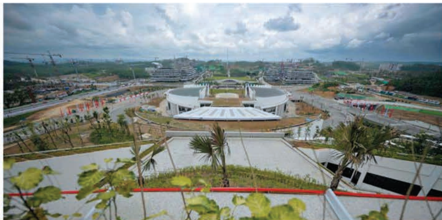
8月17日，印尼新首都努山塔拉的在建建筑。
