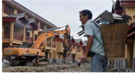
▲ 2018年8月14日，建设中的凤凰县禾库镇易地扶贫搬迁安置区
