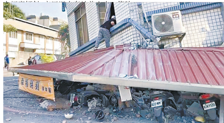
花莲一处早餐店完全倒塌
